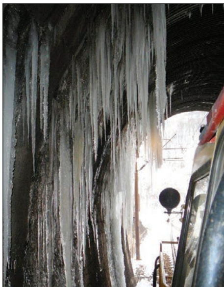
Nakon čišćenja snijega, uslijedilo je skidanje ledenica u tunelima
